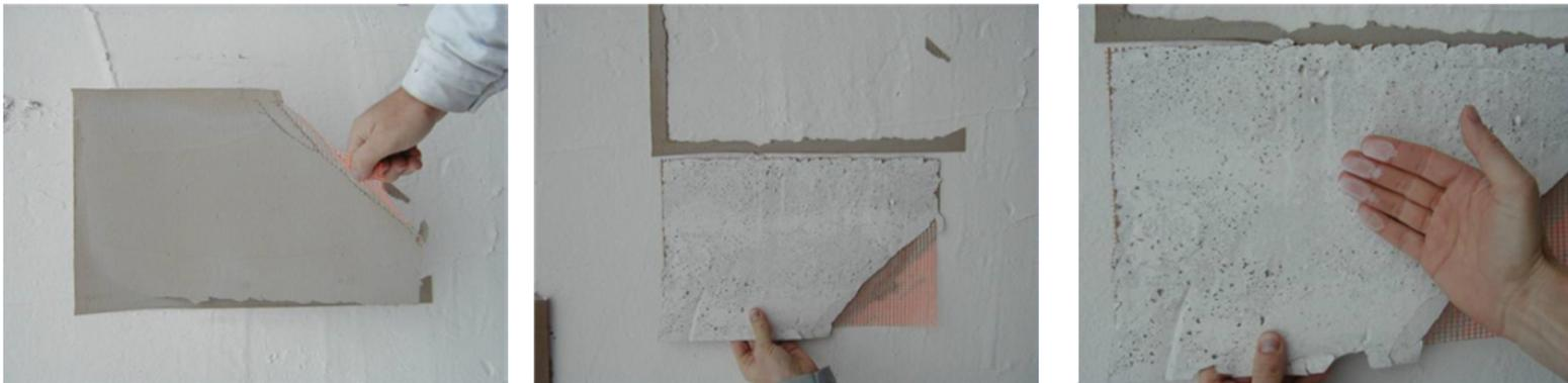
Malta di rasatura + rete di armatura strappata ➔ supporto non portante
