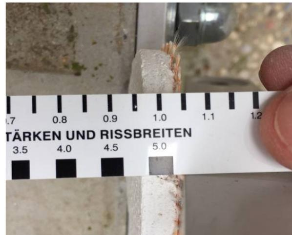
Rasatura non conforme nel posizionamento della rete di armatura
