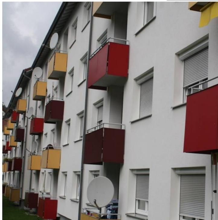
Ristrutturazione effettuata nel 2006 tramite raddoppio con EPS (10 cm ): nessuna carenza individuata.
