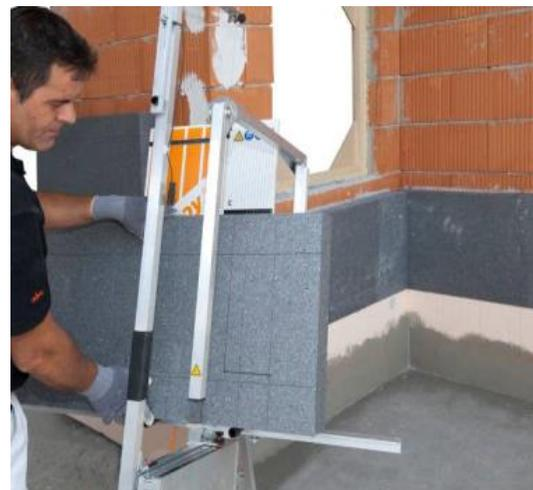
Applicazione del pannello sulla muratura dal basso verso l'alto, con il lato lungo orizzontale ed a giunti sfalsati per almeno 25 cm.
