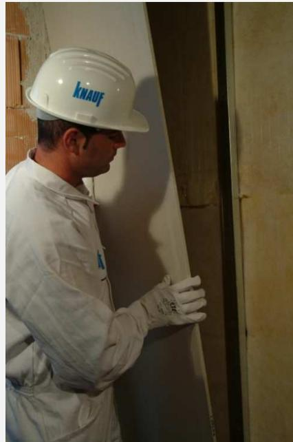
*3- Posa dell'isolante e delle lastre*
