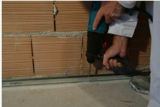
*1- Tracciamento e posa delle guide a pavimento e soffitto*
