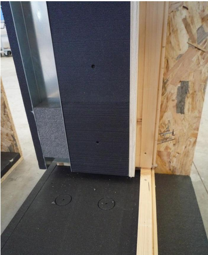
*L'isolante viene incollato e fissato con viti eccetto la parte terminale fissata solo meccanicamente*
