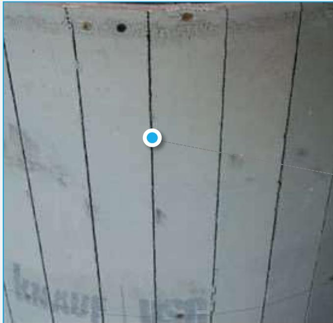
La continuità viene ripristinata con lo strato di rasante cementizio, armato con l'apposita rete di rinforzo.
