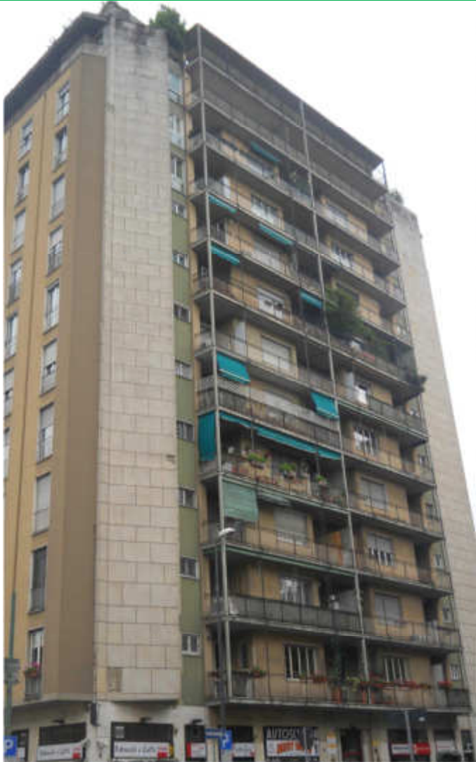
Edificio prima dell'intervento
