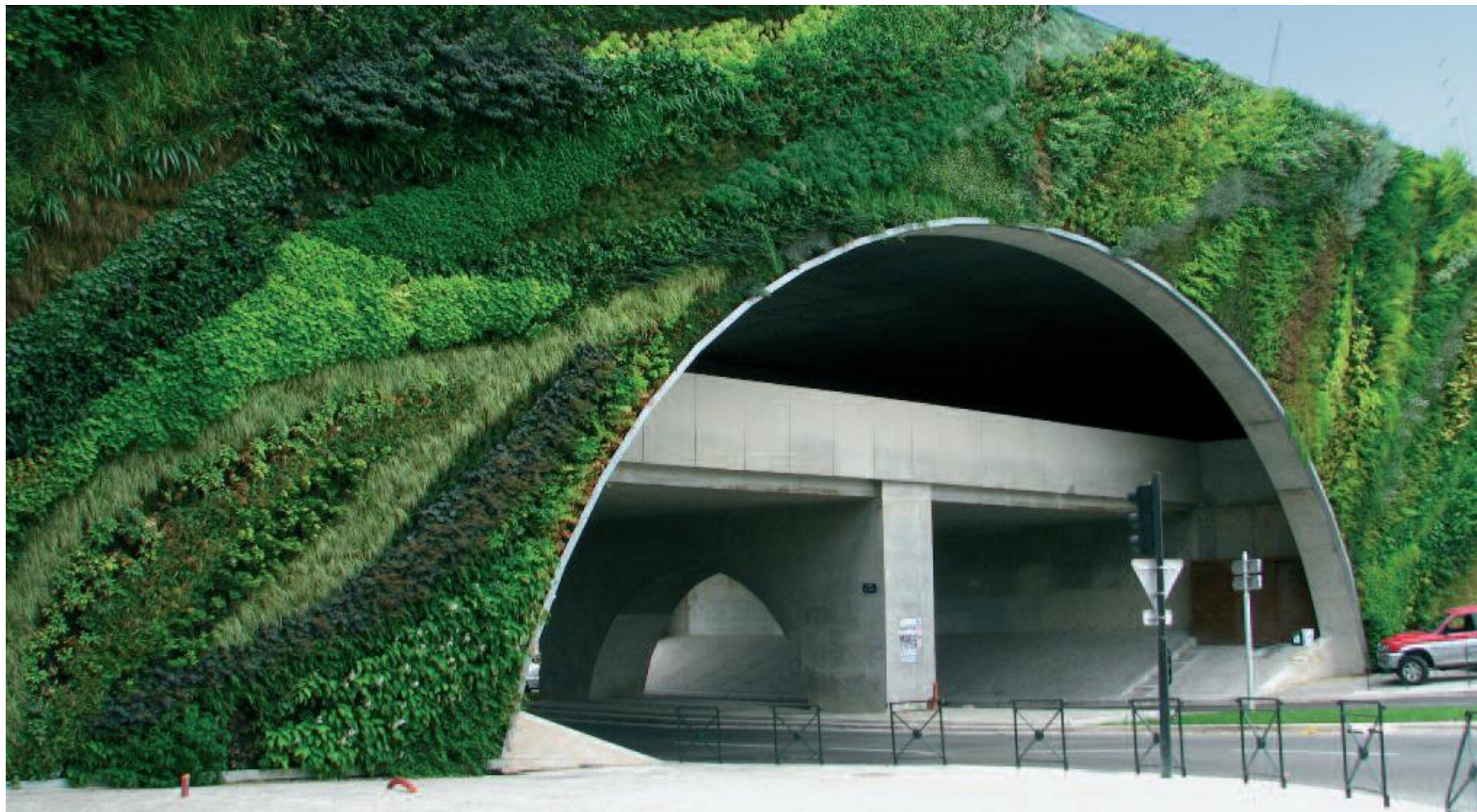
“ Mur Vegetal ”, Pont Juvénal (Aix-en-Provence). Progetto di verde verticale esterno curato da Patrick Blanc. Esempio di verde verticale con piante a dimora in superfici radicabili verticali.
