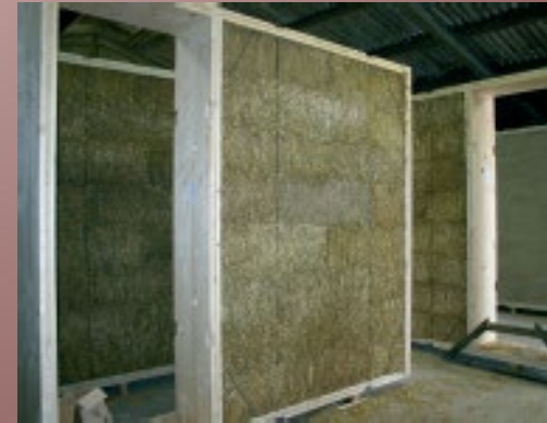
La paglia compressa per aumentare le prestazioni energetiche e garantire la stabilità.
