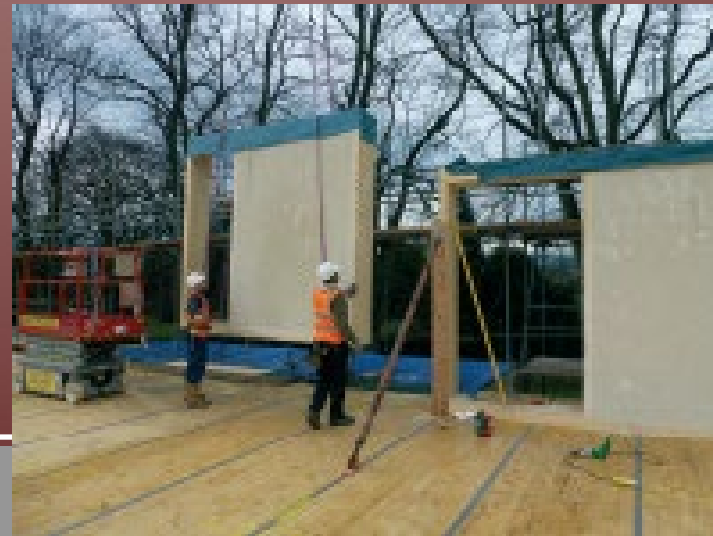
I pannelli trasportati in cantiere come unità sigillate e manovrati con l'aiuto di attrezzature di sollevamento.
