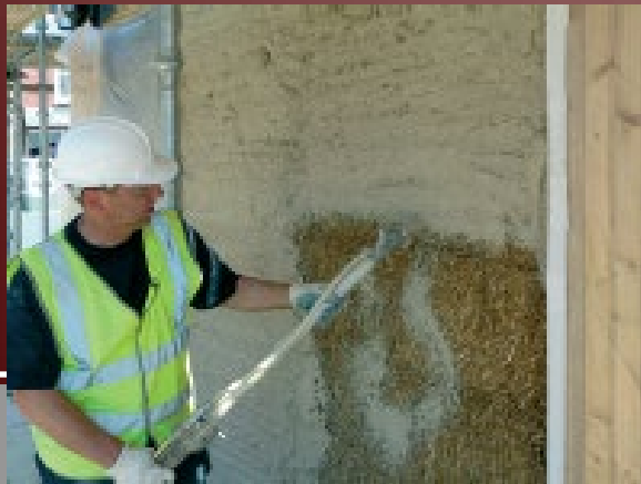
Rivestimento protettivo, a base di calce, applicato a spruzzo direttamente sulla paglia. Un ulteriore strato rasante sarà poi applicato manualmente.
