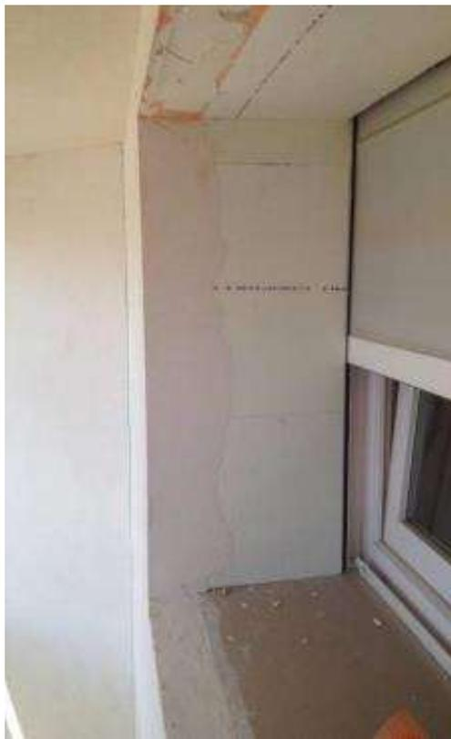
Importante isolare anche gli intradossi delle finestre per **eliminare i ponti termici**.
