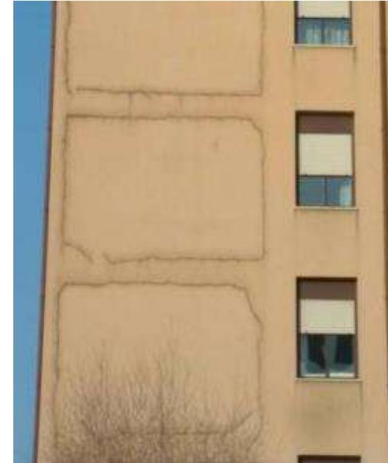
L'isolamento dall'esterno consente di evitare e risolvere patologie in facciata. Garantisce un'elevata protezione e la quiete termica delle murature
