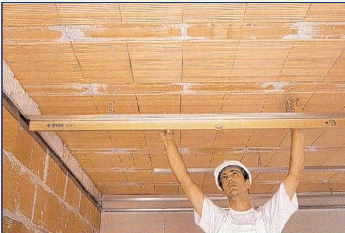
Posizionamento dell'orditura primaria
