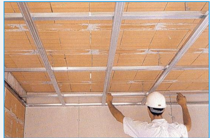
Posizionamento dell'orditura secondaria
